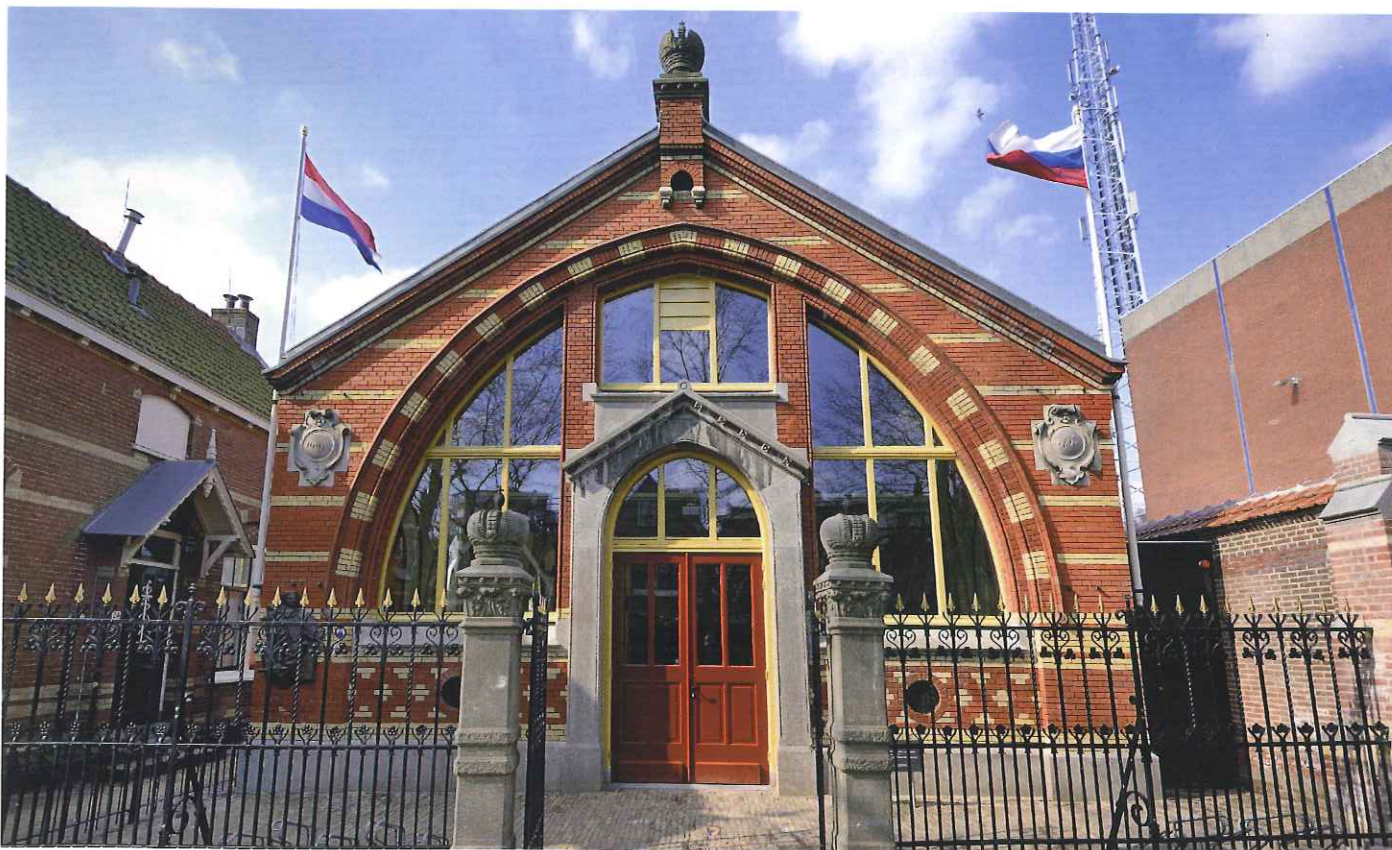
Het Czaar Peterhuisje aan de Krimp in Zaandam waar Bouwintentie het bouwkostenmanagement en de bouwdirectie voerde
